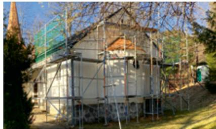
im verdeckten Bereich, ertüchtigt. Putzabplatzungen an den Traufgesimsen konnten im Zuge der Gerüststellung ebenfalls ausgebessert sowie die Dachrinnen gereinigt werden. Teile des Gerüsts an der Südost-Ecke des Gebäudes bleiben noch während des April 2024 stehen, um den Sturzbereich des Sakristeifensters zu sanieren.
